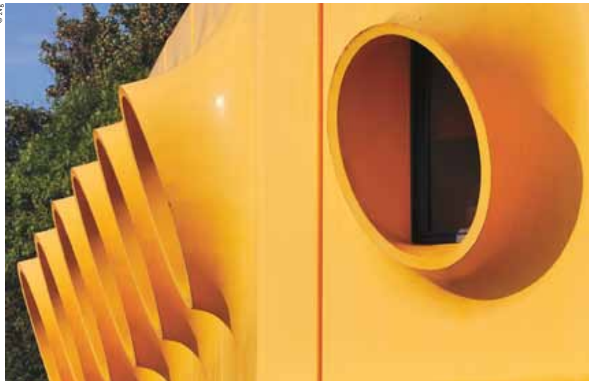
Die auffällige Brücke über der Autobahn bei Basel erinnert an ein Unterseeboot.
